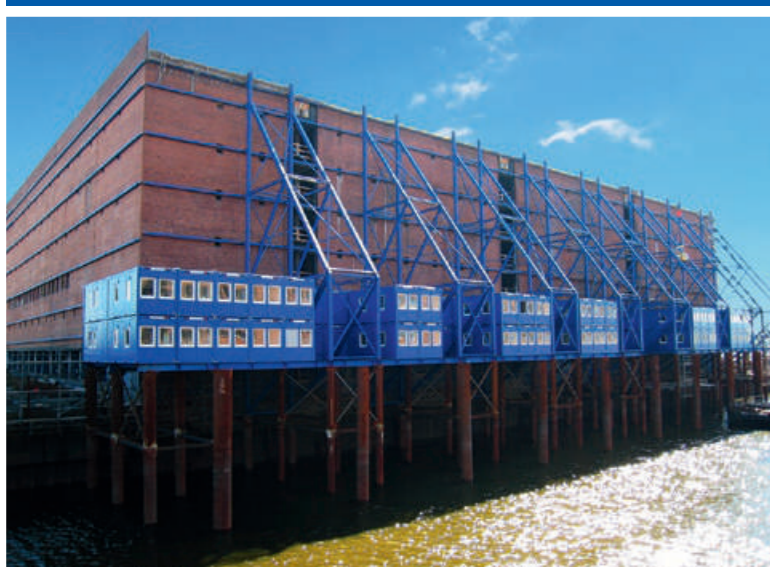
Строительный офис на площадке в особых условиях
