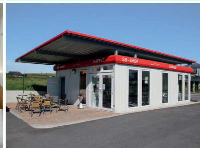
Магазин на заправочной станции
